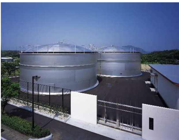
第 2 低区配水場（坂戸地内）
