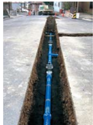
耐震管布設替工事
