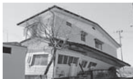
東日本大震災 (平成 23 年 3 月・宮城県土木部提供)
