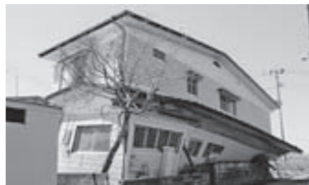
東日本大震災 (平成23年3月・宮城県土南部提供)
