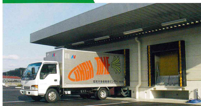
配送車への給食の積み込みは、外気との接触を抑えたドックシェルターから行います。
