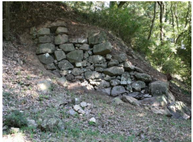
二の丸西面石垣
