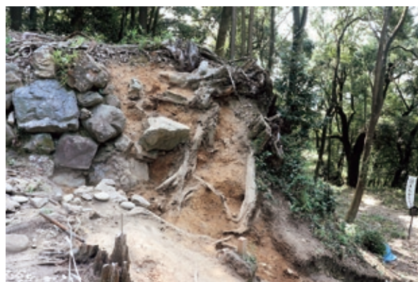
枡形虎口（南面石垣）D地点（南西より）
