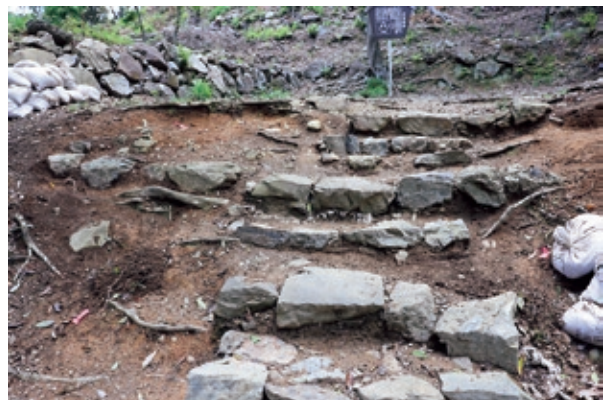
石段部分上段（南西より）
