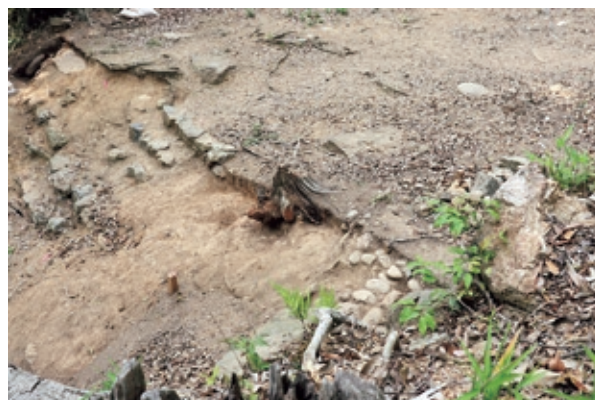
石段上段検出状況（南東より）
