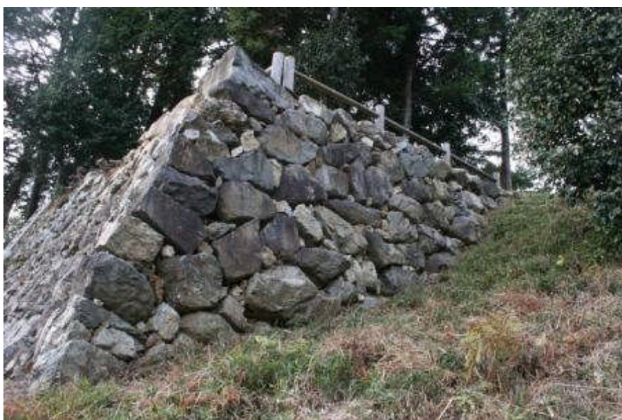
出丸南石垣（南より）
