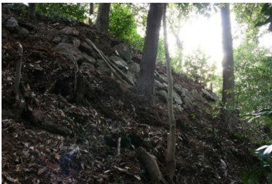
三の丸北側石垣（北より）
