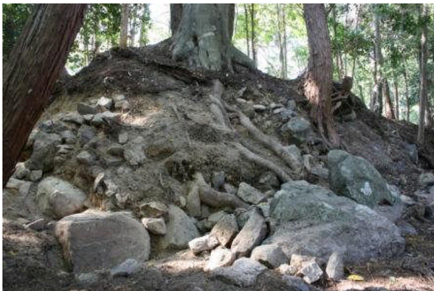
北側一段目石垣東隅部分（東より） 石垣の石が落ちており、破城の際に壊されたと考えられます。 斜面に見える小さな石は石垣の裏に入れた裏込め石です。
