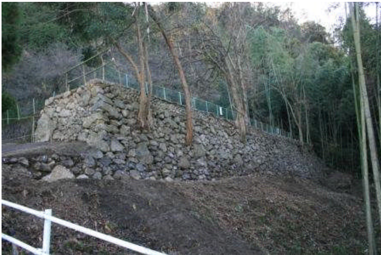
伝米蔵跡北面石垣全景（北より）
