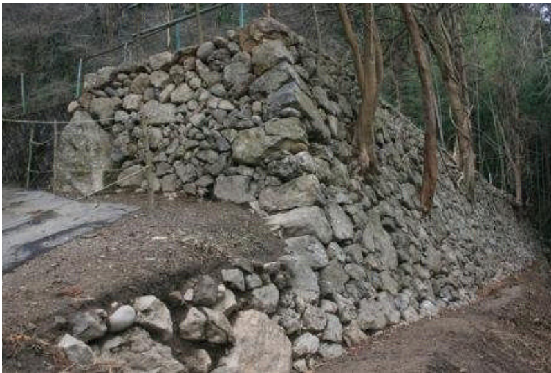
石垣東面（東より）
