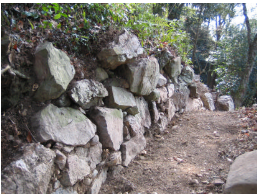
写真 18 北斜面西突出部上段 石垣（北東から）
