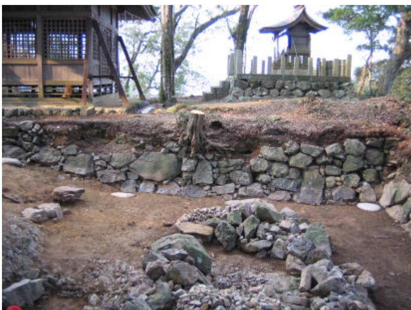
写真6 虎口（入口）北側石垣 （南から）
