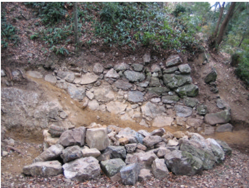
写真 11 東斜面石垣北側 (東から)
