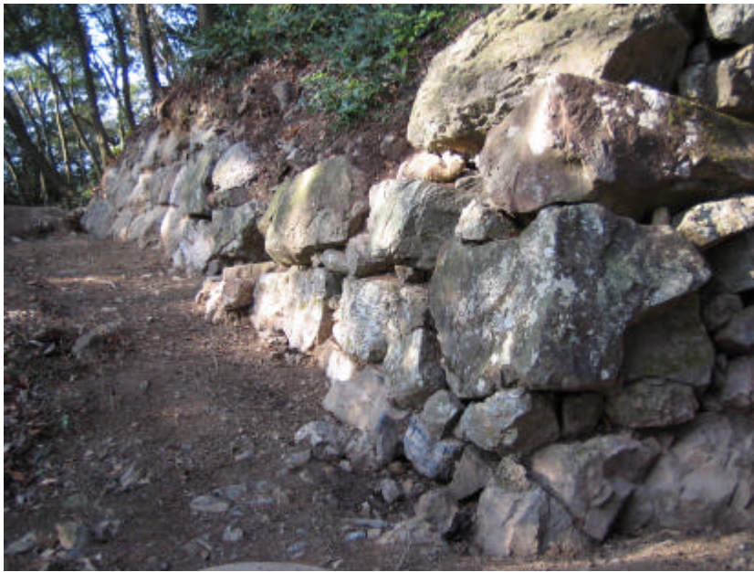
写真 13 西斜面南突出部西側 石垣（南西から）
