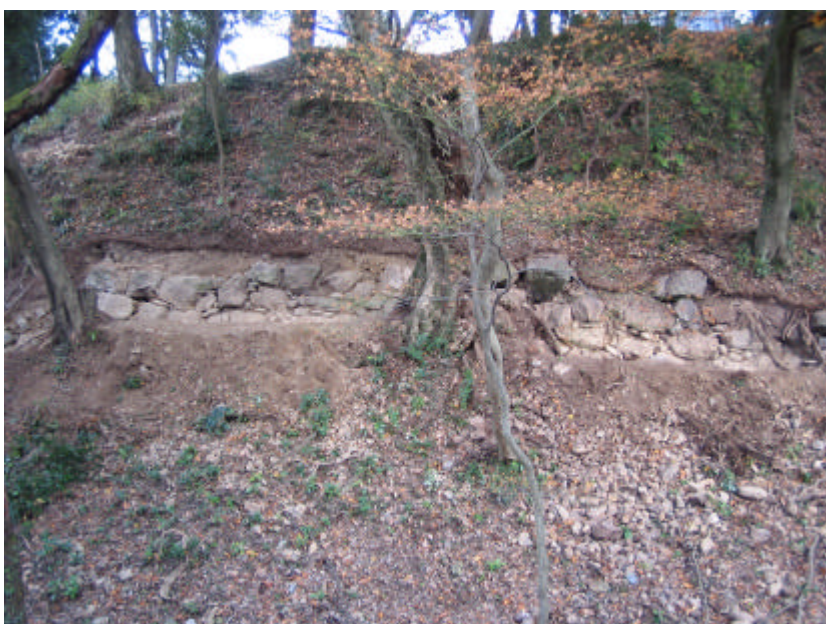
写真 15 西斜面北突出部下段 石垣（西から）
