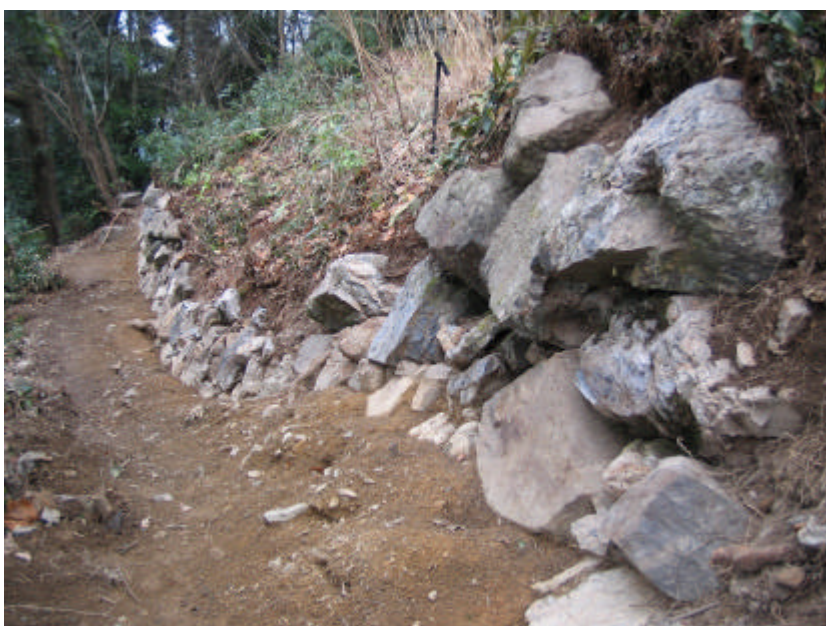
写真 21 北斜面東側石垣 （北西から）
