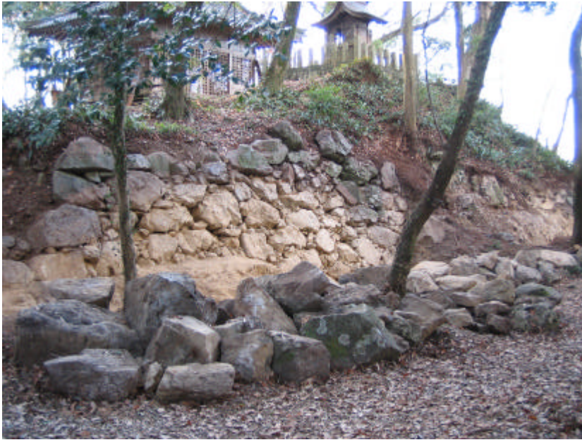
写真 10 東斜面石垣南側 (南東から)
