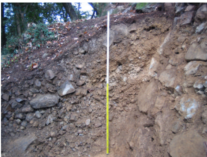
写真9 東斜面石垣の土砂の 堆積状況(北から)
