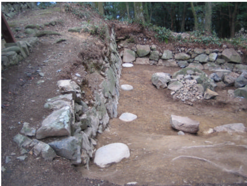
写真8 虎口北側の礎石列 (西から)
