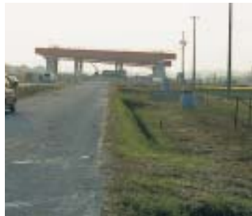
建設が進む東海環状自動車道
