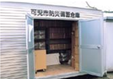
乾パンなどが整然と保管されている防災備蓄倉庫
