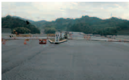
建設が進む東海環状自動車道(柿田)
