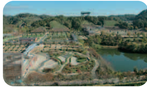
整備中の同公園西エリア(11月4日)
