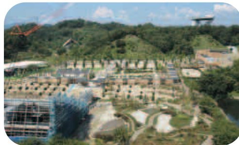
整備中の同公園西エリア(7月9日)
