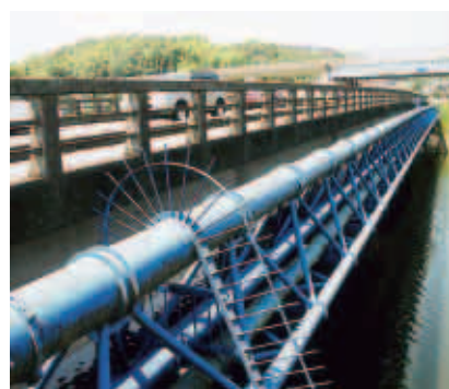
可児川に掛かる水道橋（下恵土）
