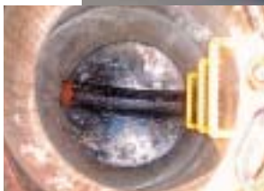
清掃してきれいになった下水道管
