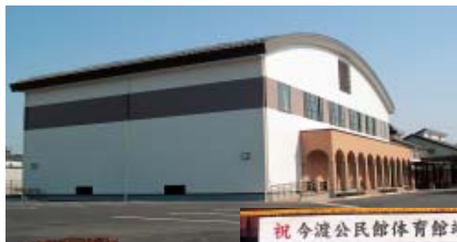
完成した体育館
