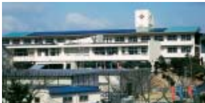
新北舎の屋根には太陽光パネルを設置
