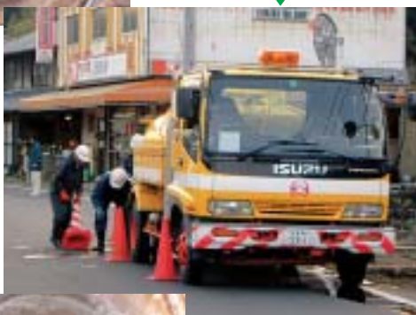
高圧洗浄車で清掃作業中
