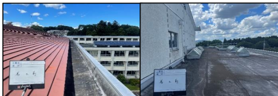
屋根防水(改修前)
