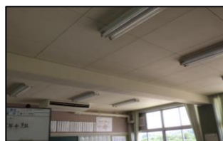
校舎教室照明(改修前)
