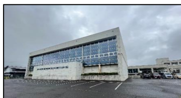
屋根・外壁(改修前)
