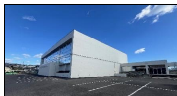
屋根・外壁(改修後)
