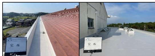
屋根防水(改修後)
