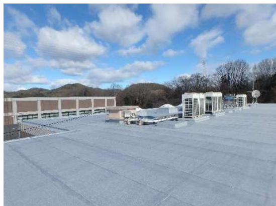
屋根防水改修工事(帷子地区センター)
