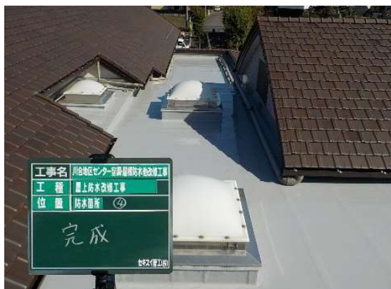
空調・屋根防水改修工事(川合地区センター)
