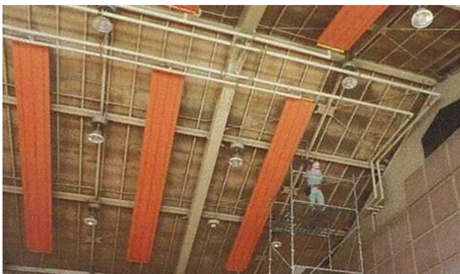
体育室照明交換工事
