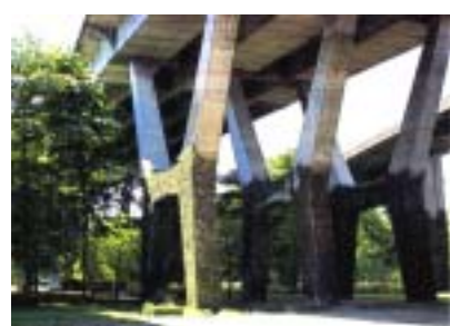
公共構造物の緑化
