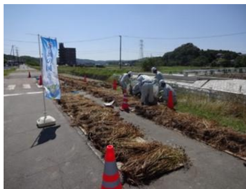
写真：防除作業の様子（中郷川河川堤防）
