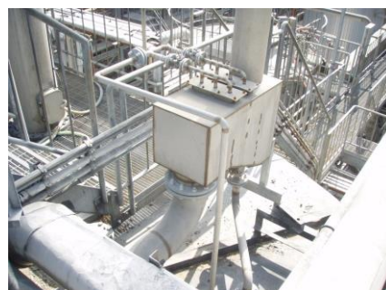
シャワー設置
