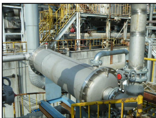
臭気ガスの熱交換器
