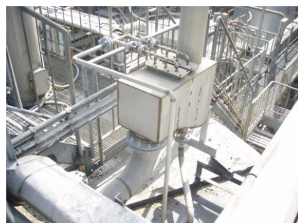
シャワー設置
