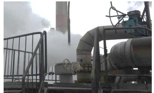
**【改善後】** 温度計でブロー温度を監視し、高温にならないようにブローラインに新たに黒液を注入したことで、流出のリスクを軽減しました。
