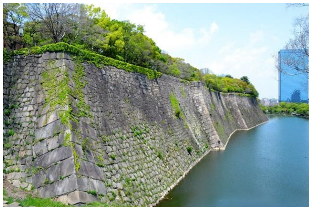
資料 41 大坂城跡内堀（東面）石垣
