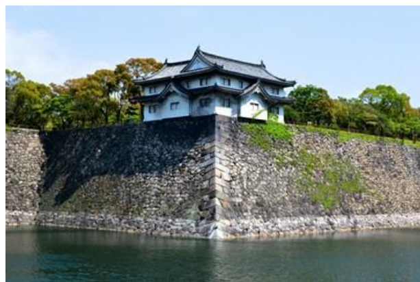
資料 40 大坂城跡北外堀石垣（櫓は乾櫓）
