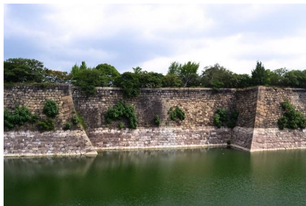
資料 43 大坂城跡南外堀石垣②
