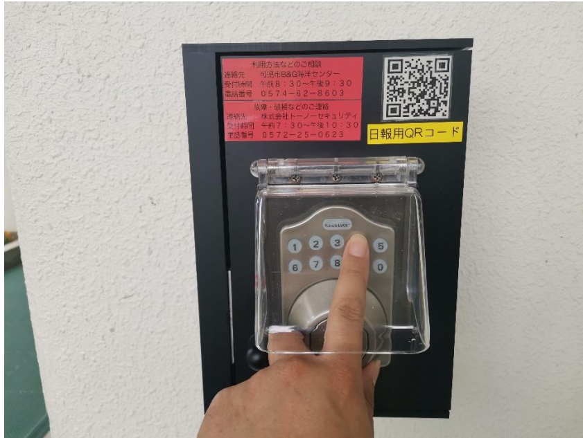
体育館玄関前
