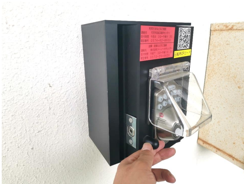
体育館玄関前
