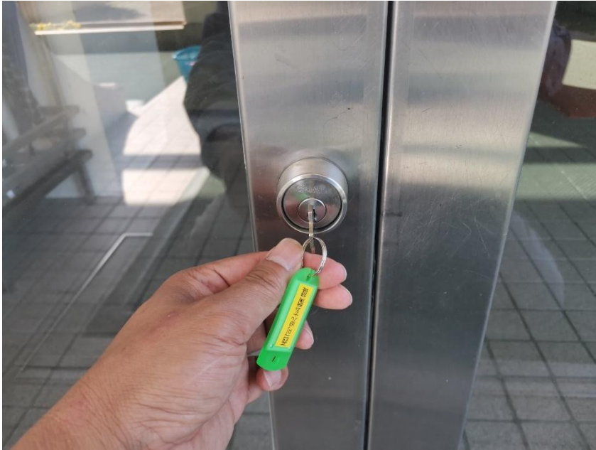
体育館玄関前
