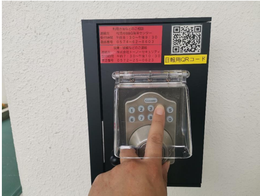
体育館玄関前
