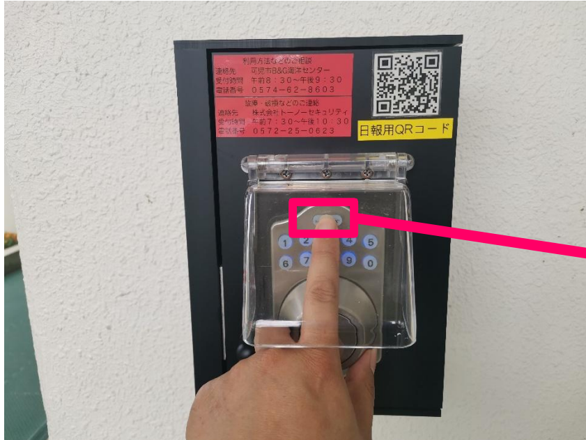
体育館玄関前
