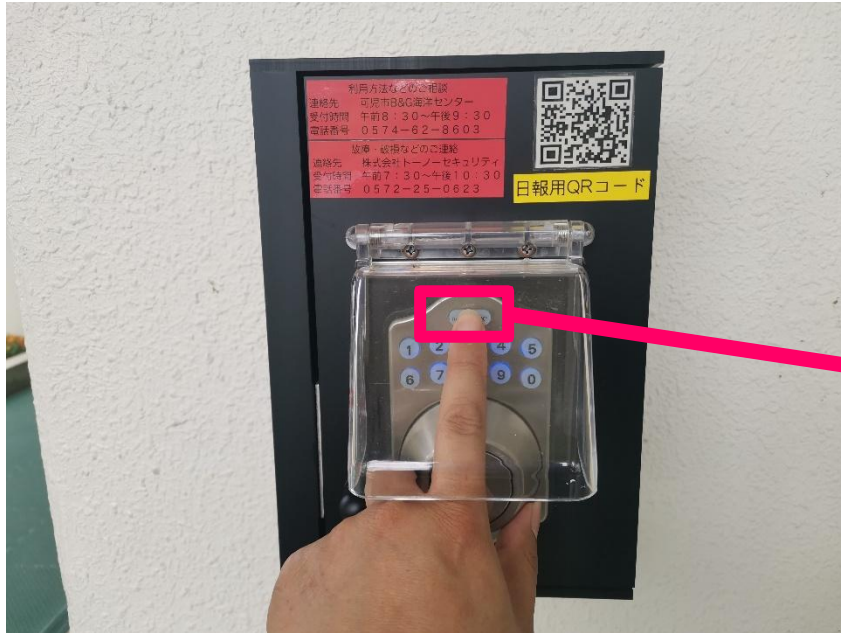
体育館玄関前
