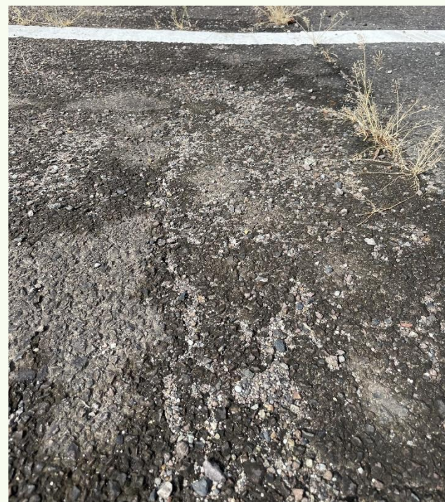
舗装のひび割れ・剥離
