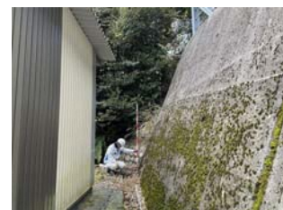
対策施設の確認
