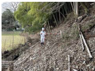
斜面の勾配・高さを確認
