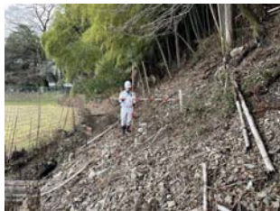
斜面の勾配・高さを確認
