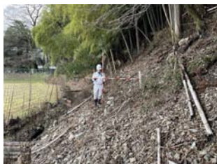
斜面の勾配・高さを確認
