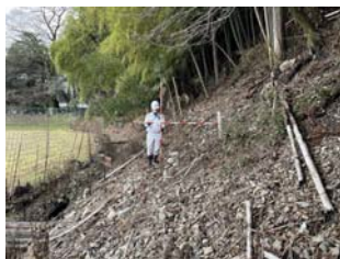
斜面の勾配・高さを確認
