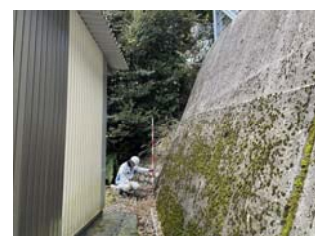
対策施設の確認
