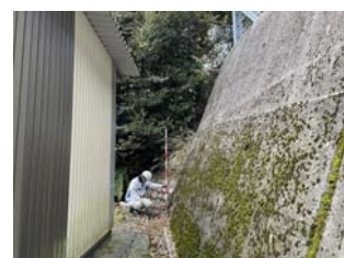
対策施設の確認
