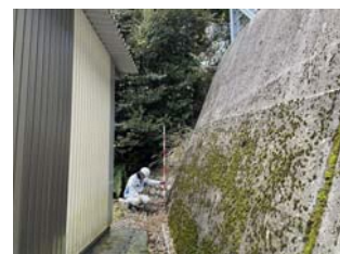
対策施設の確認
