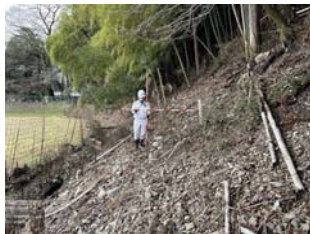
斜面の勾配・高さを確認
