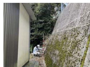
対策施設の確認
