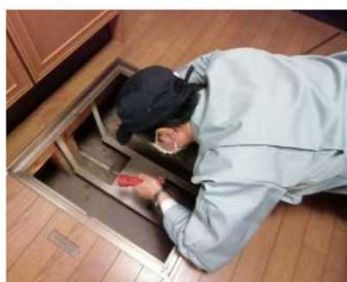
「土台・床組、基礎」調査の様子
