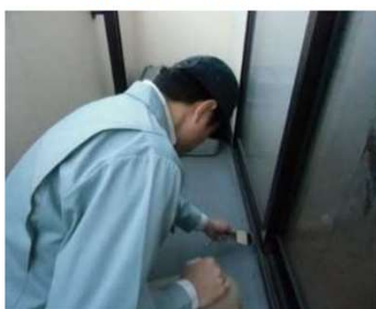
「外部（バルコニー）」調査の様子
