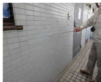
「外部（外壁）」調査の様子
