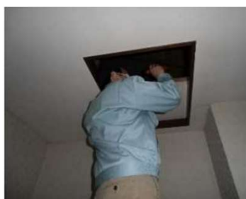
「小屋組・梁」調査の様子
