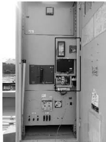
【高圧饋電盤面取付参考】
