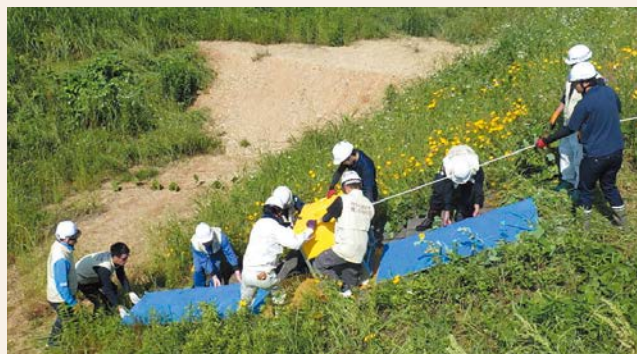
排水ポンプ設置訓練
