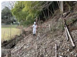
斜面の勾配・高さを確認
