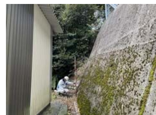
対策施設の確認
