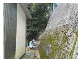
対策施設の確認
