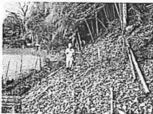
斜面の勾配・高さを確認
