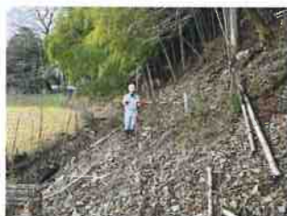
斜面の勾配・高さを確認
