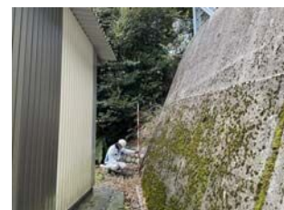
対策施設の確認
