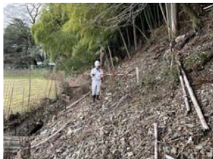
斜面の勾配・高さを確認
