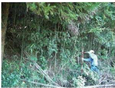
斜面の勾配・高さを確認
