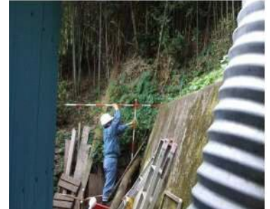
対策施設の確認
