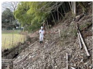
斜面の勾配・高さを確認
