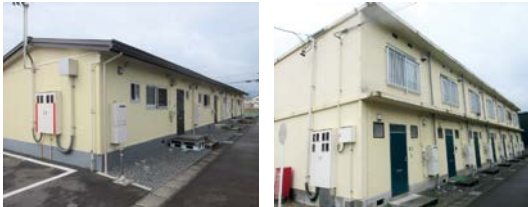
東野住宅平屋建 東野住宅 2 階建
