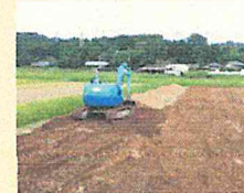
土層改良（客土）
