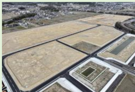
造成後の可児御嵩インターチェンジ工業団地
