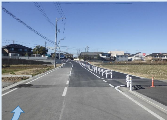
工事前(左)と工事後(右)の市道117号線
