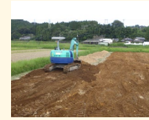
土層改良（客土）
