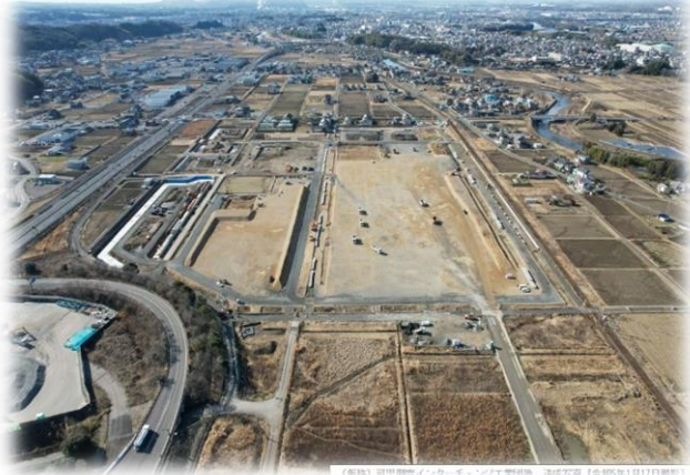
（仮称）可児御嵩インターチェンジ工業団地 造成工事（令和5年1月17日撮影）
