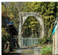
主塔 旧下渡橋
