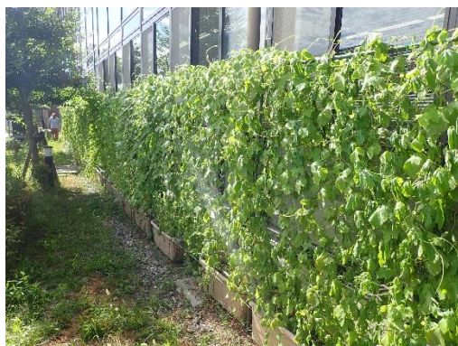
庁舎でのグリーンカーテン設置の様子
