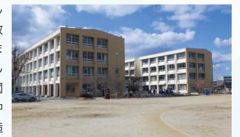
改修する蘇南中学校校舎
