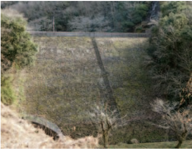
小淵ダム (久々利地区)
