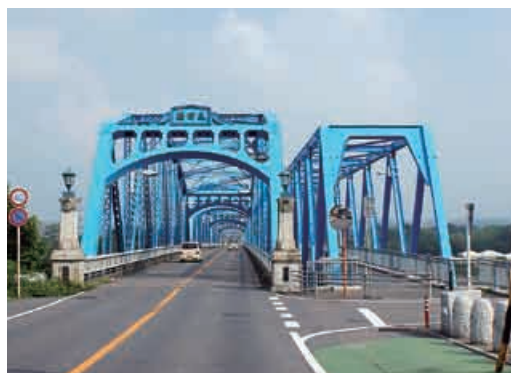
現在の太田橋
