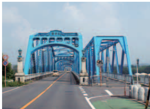
現在の太田橋
