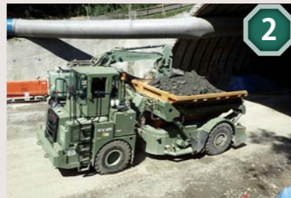
2 掘り出した土石をベッセルダンプで運び出します。
