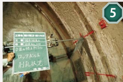
5 4mのロックボルトを打ち込み、岩盤を支えます。
