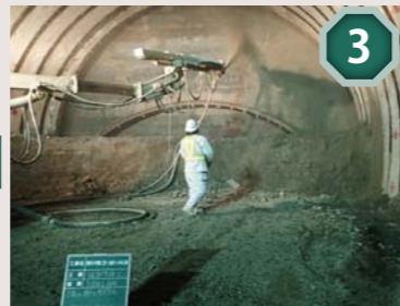
3 コンクリートを吹き付けて断面を固めます。④の後にも再度吹き付けます。
