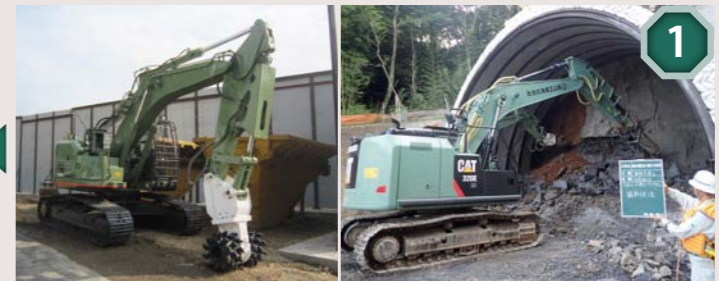
1 岩肌を削るツインヘッド(写真左)と叩き割る大型ブレイカー(写真右)。この2台から掘削が始まります。
