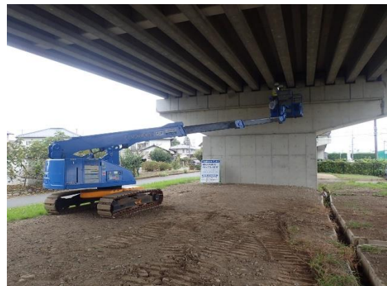
高所作業車による点検
