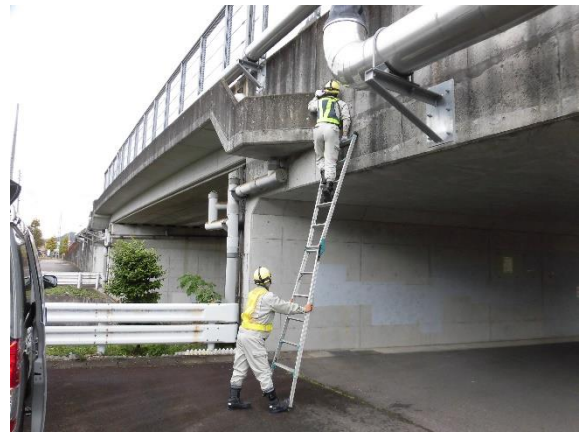
近接目視点検の状況
