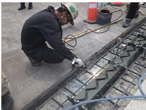
伸縮装置取り付け
