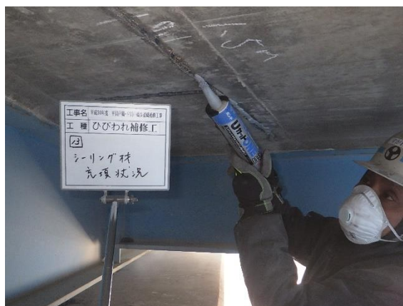
シーリング材充填
