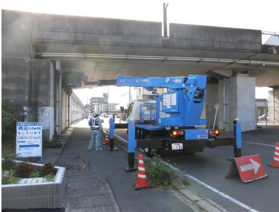
橋梁点検車による点検
